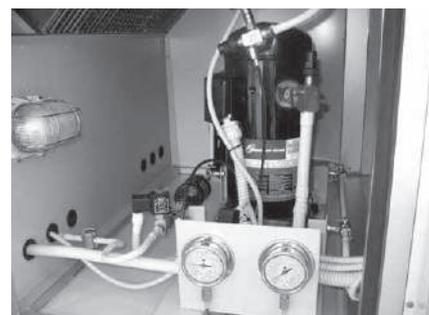
Встроенная система жидкостного охлаждения
