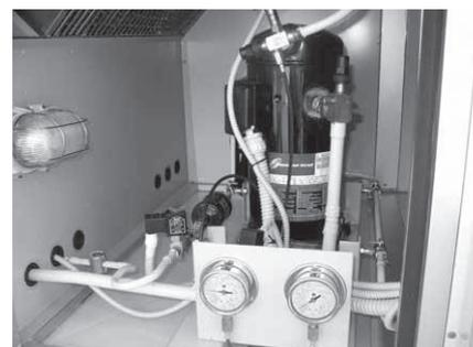
Встроенная система жидкостного охлаждения
